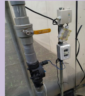
▲ 溫室灌溉管路安裝控制器及電磁閥，依據累積光度自動灌溉
